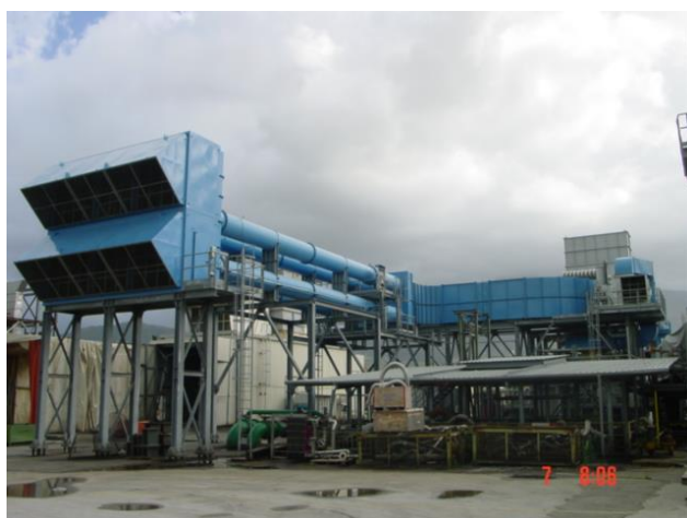
Rysunek 46 System wlotowy TG zaprojektowany do dokładnego pomiaru przepływu powietrza wlotowego ( W_{Sin} ). Przekrój przez przeływomierz zwężkowy z kryzą pomiarową.
